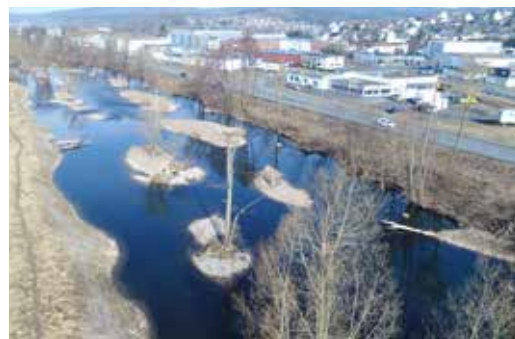
Titel Ortsnahe Renaturierung mit Aufweitung des Abflussquerschnittes um das Dreifache
