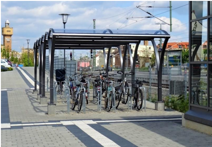
Geförderte Fahrradabstellanlage am Bahnhof Merseburg
