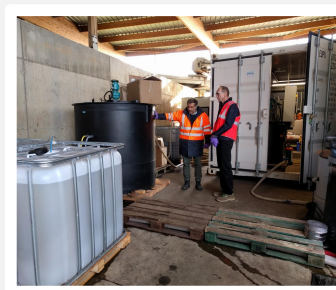
Pilotanlage in Tergnier
