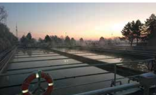
Kläranlage Erdinger Moos
