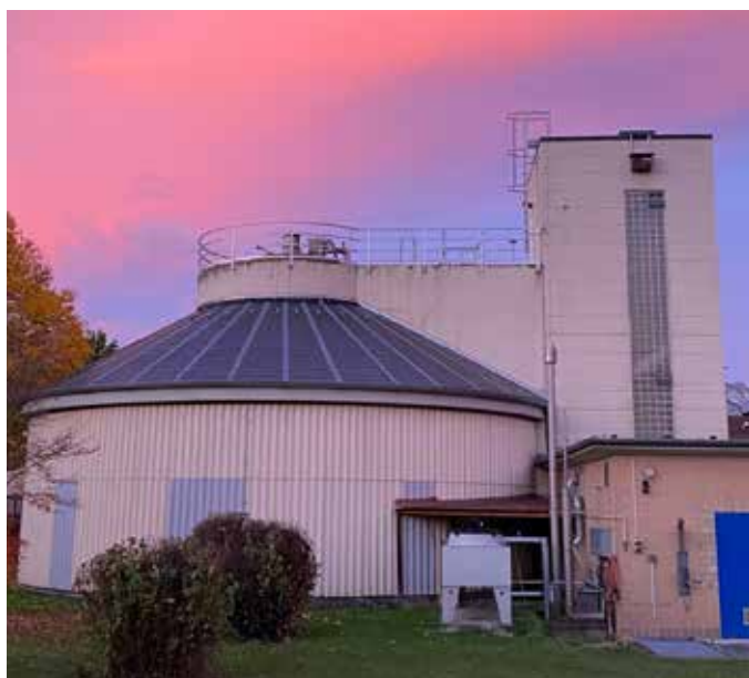
Faulturm Kläranlage Melsungen
