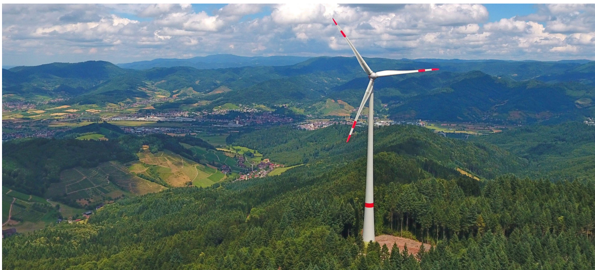
Abbildung 11: Anlage im Windpark Rauhkasten/Steinfist, Ortenaukreis (Baden-Württemberg)
