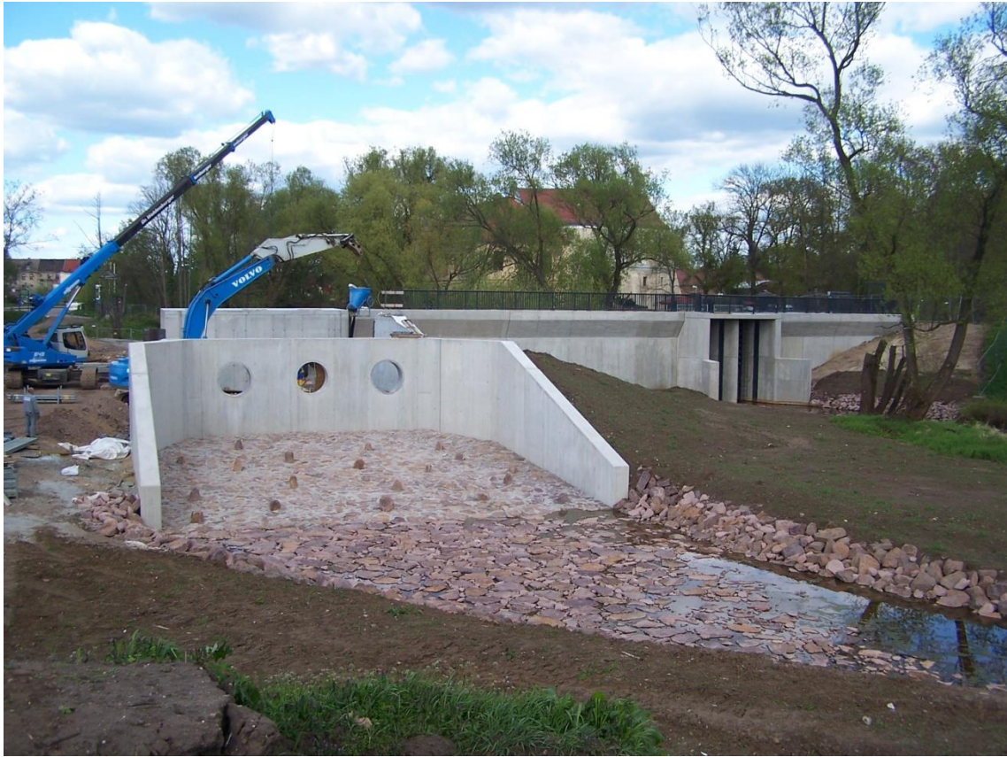
Bild 7: Baustelle Schöpfwerk Roßlau/ Elbe im Mai 2014
