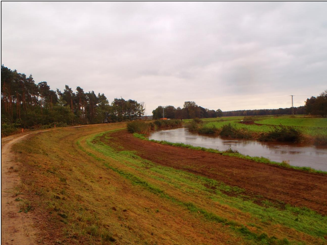
Bild 5: Vorlandmanagement an der Schwarzen Elster unmittelbar nach Abtrag von Uferrehnen
