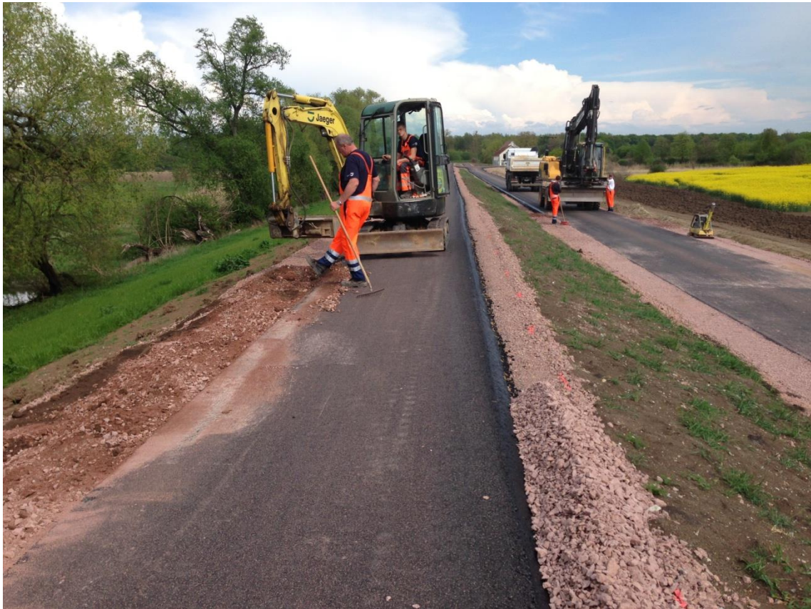
Bild 6: Endarbeiten im Bereich der verbauten Deichbruchstelle Breitenhagen Ende April 2014
