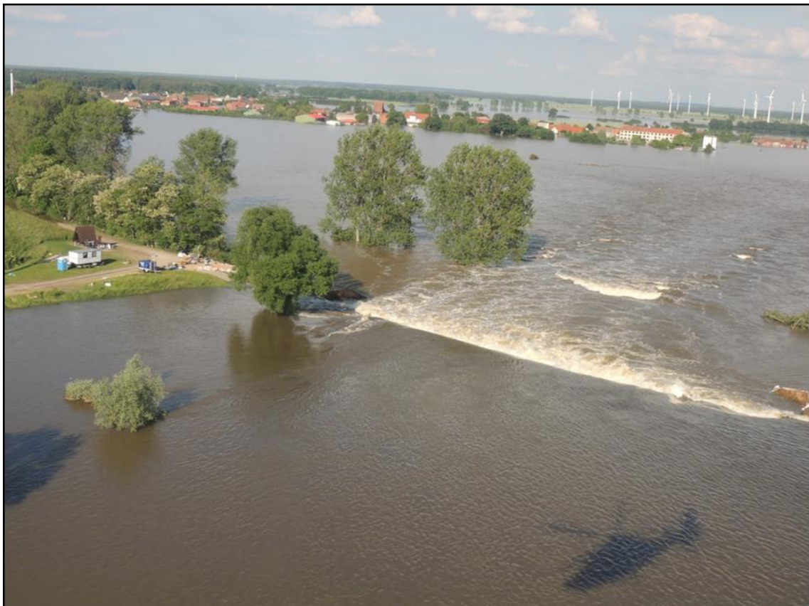
Bild 2: Deichbruch bei Fischbeck/ Elbe
