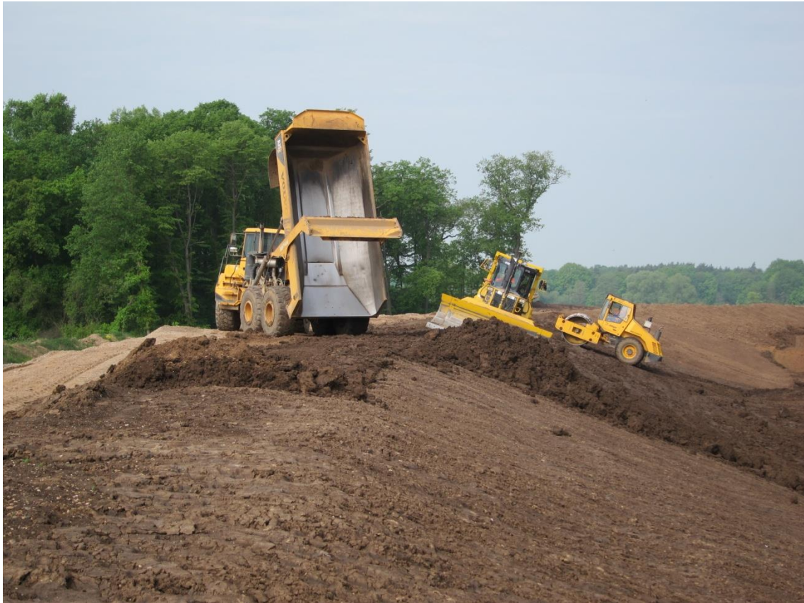
Bild 3: Deichbau Lödderitzer Forst
